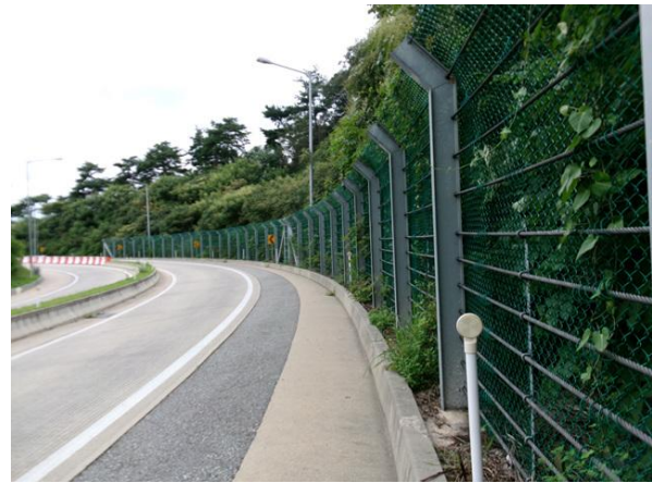
도로, 낙석방지울타리 전경
