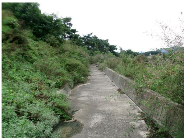
1소단 배수로 전경
